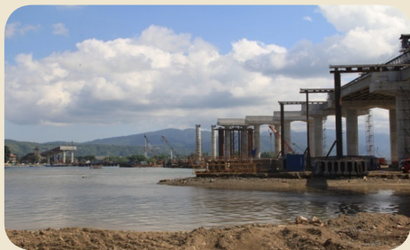
Jembatan Merah Putih-Ambon
